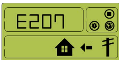
[Figura 4-24: Occorrenza di evento, evento di collegamento CC inverter normale]
