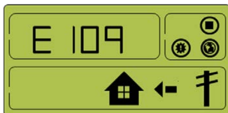
[Figura 4-20: Occorrenza di evento, protezione per sovratensione batteria]
